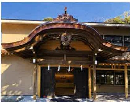
正面玄関の特色は「唐破風」の屋根です。旧社務所の玄関の材を残し、腐朽部分を除きそのまま利用します。彫刻類は古材が生きてます。
